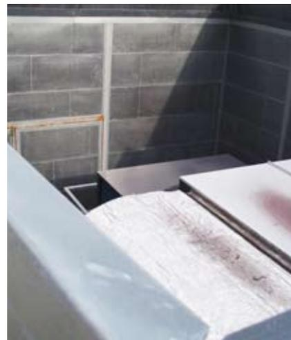
Ejemplo de **pantalla acústica** en sala de máquinas, situada en cubierta de edificio industrial colindada por viviendas. Garantizada **reducción** significativa de **contaminación acústica**.
