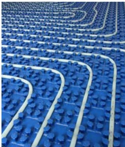
Ejemplo de climatización por **Sistema de Suelo Radiante**. Proporciona mayor confort con **temperaturas constantes** y uniformes en cada habitación, **sin obstaculizar** el espacio habitable.
